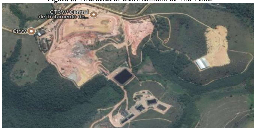
Figura 3. Vista aérea do aterro sanitário de Vila Velha.
